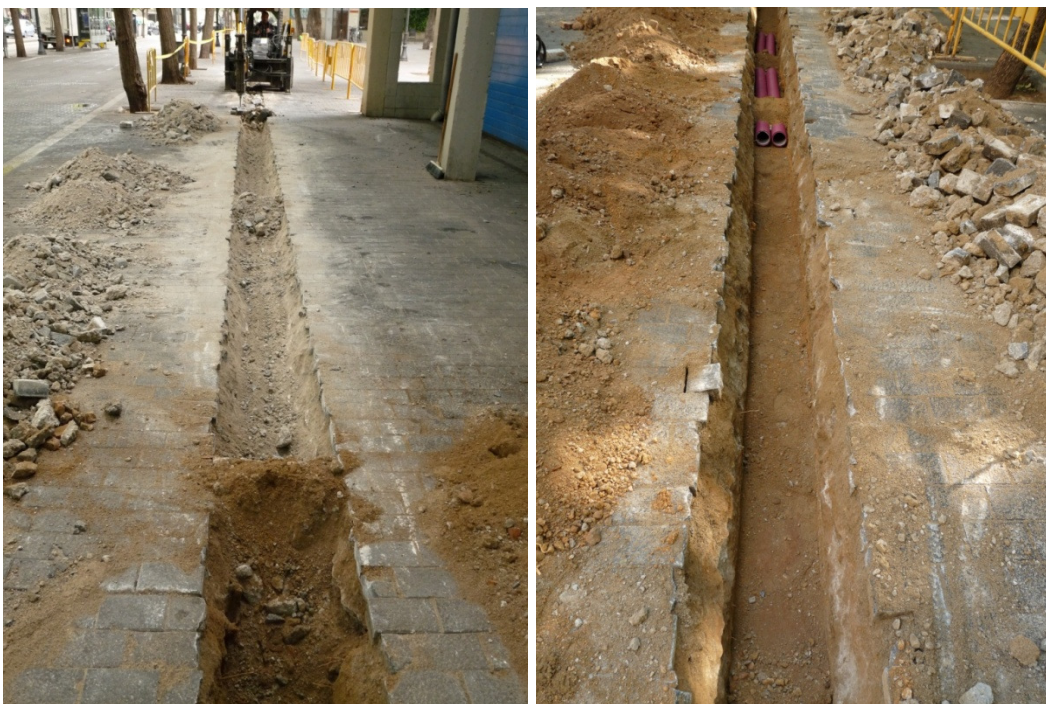
Foto número 3, vista de la rasa 200 en procés d'obertura (foto de l'esquerra), i Foto número 4, vista de la rasa 200, amb els tubs parcialment col·locats (foto de la dreta).
