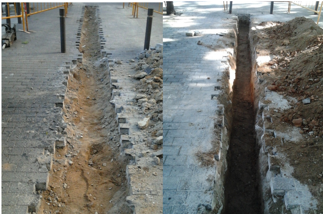
Foto número 1, vista de la rasa 100, a l'esquerra amb el paviment estret, i a la dreta foto número 2 vista de la rasa 100 a la cota final.
